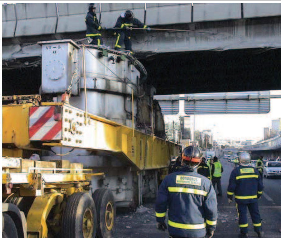
Labores para retirar el vehículo pesado encajado ayer bajo un puente en el kilómetro 4,400 de la M-40. AYTO. MADRID
